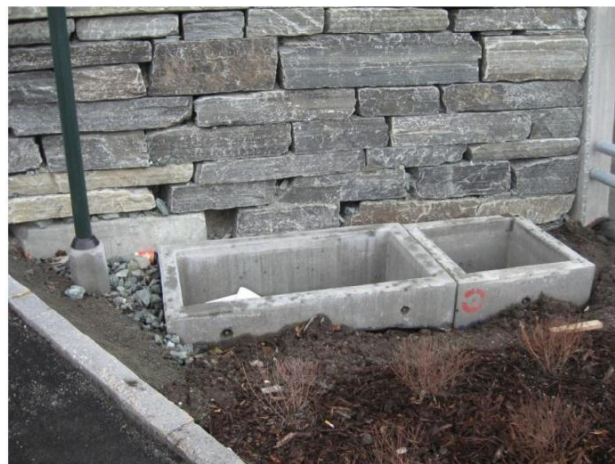
Základ pre kontrolný panel
