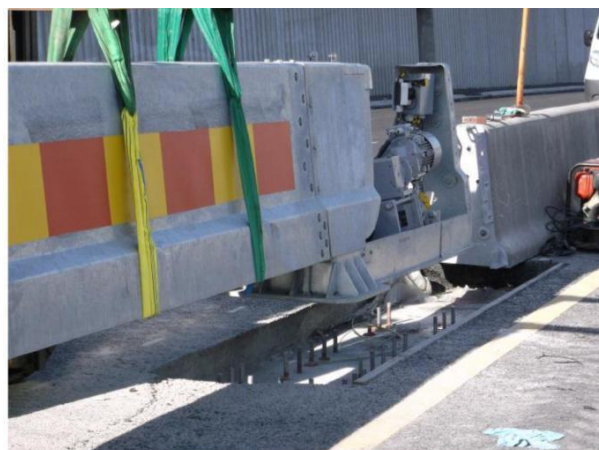
Inštalácia priechodu CADO (spojovací rám spolu s výklopnou časťou)
