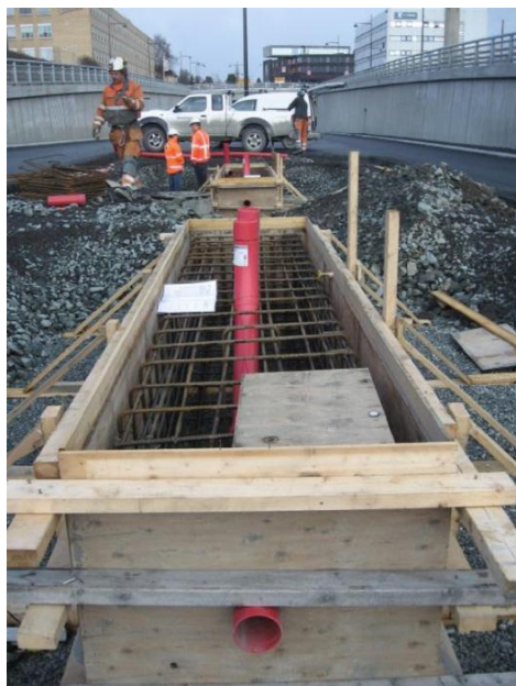
Príprava betónových základov pre priechod CADO
